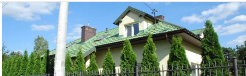
Zdjęcie 11 Zdjęcie budynku o agresywnej kolorystyce dachu (jaskrawa zieleń), która narusza ład przestrzenny, ponieważ sąsiadujące zabudowania mają dachówkę w ciemnych odcieniach czerwieni 26
