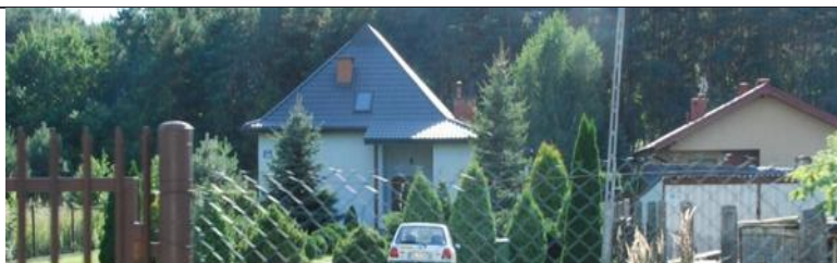
Zdjęcie 14 Zdjęcia budynków sąsiadujących ze sobą, które kolidują ze sobą kolorystycznie oraz wykończeniem zadaszenia (dwu-spadowe oraz wielospadowe), co narusza ład przestrzenny 29
