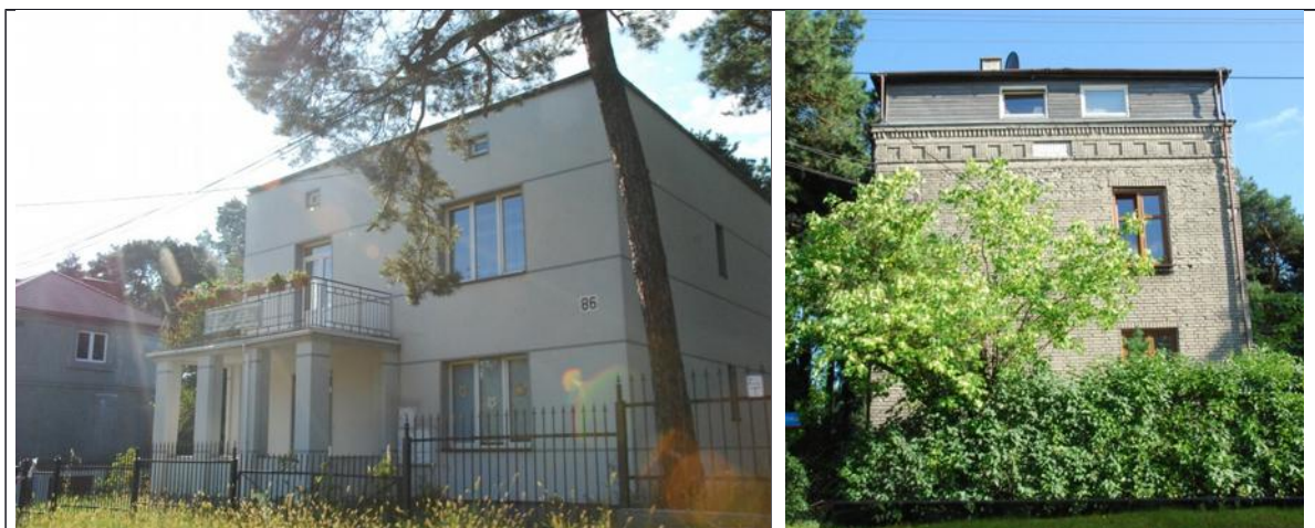
Zdjęcie 5 Widok na zabudowę tzn. "kostkową" (po lewej) oraz ceglany budynek z drewnianą nadbudową (po prawej) 8
