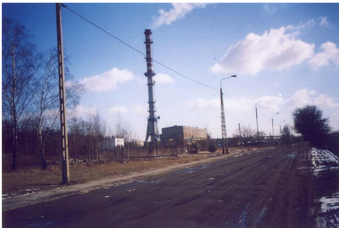
Fot. 7. Ciepłownia Łajski
