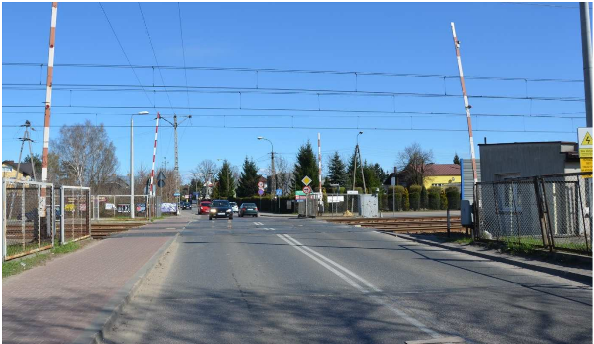
Rys. 1.2 Widok na istniejący przejazd kolejowy od strony ul. Parkowej
